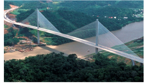
Puente Centenario, Panama City
